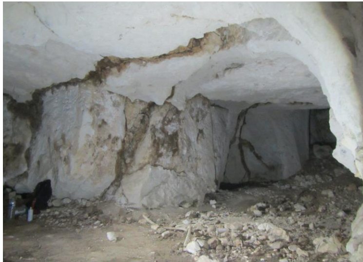
Illustration 12 : Illustration de la densité de fractures et de conduits karstiques visibles dans la carrière du Clos-Saint-Marc
