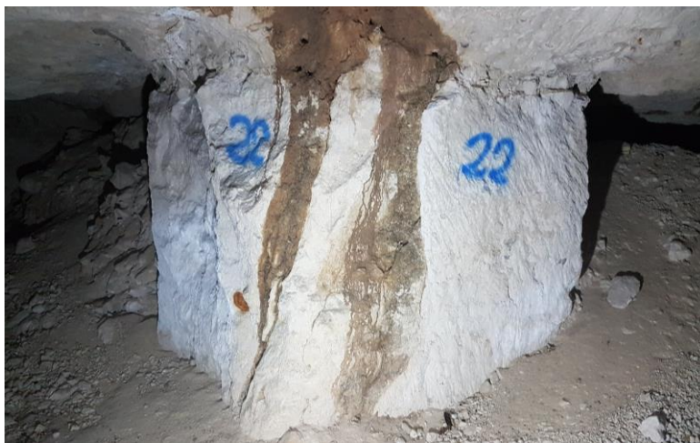
Illustration 7 : Exemple d'un pilier traversé par deux larges conduits karstiques parallèles (ici P22)
