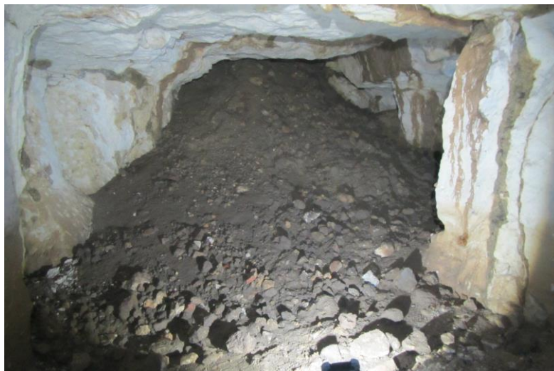
Illustration 9 : Cône d'éboulis du fontis D17, constitué de terre et de débris divers (briques etc.). Ce fontis a donc généré un effondrement en surface dans le passé
