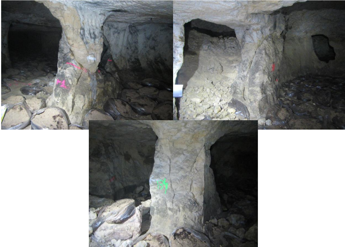
Illustration 13 : Exemples de trois piliers très fracturés mécaniquement (à gauche : P139 et à droite, P324, en bas : P134)
