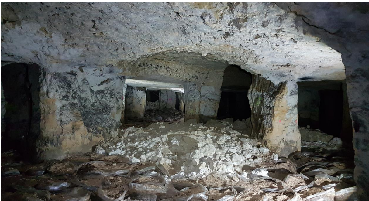
Illustration 19 : Exemple d'une chute de toit postérieure à l'exploitation des champignons, dans la mesure où les éboulis recouvrent les sacs de culture
