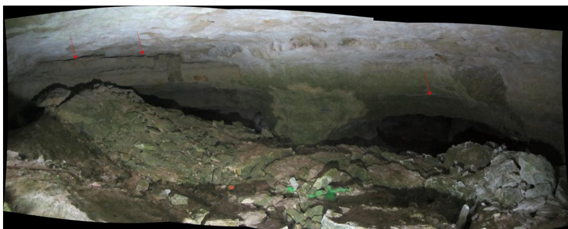
Illustration 15 : Panorama de la grande salle située à l'entrée de la carrière (photo prise avant la création du nouveau pilier de soutènement). Les importants décollements situés en périphérie de cette instabilité sont repérés par des flèches rouges
