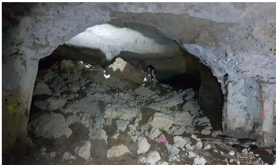
Illustration 18 : Vue sur l'ébauche de cloche de fontis D85, au droit de laquelle les épaisseurs de recouvrement sont réduites à 2 m
