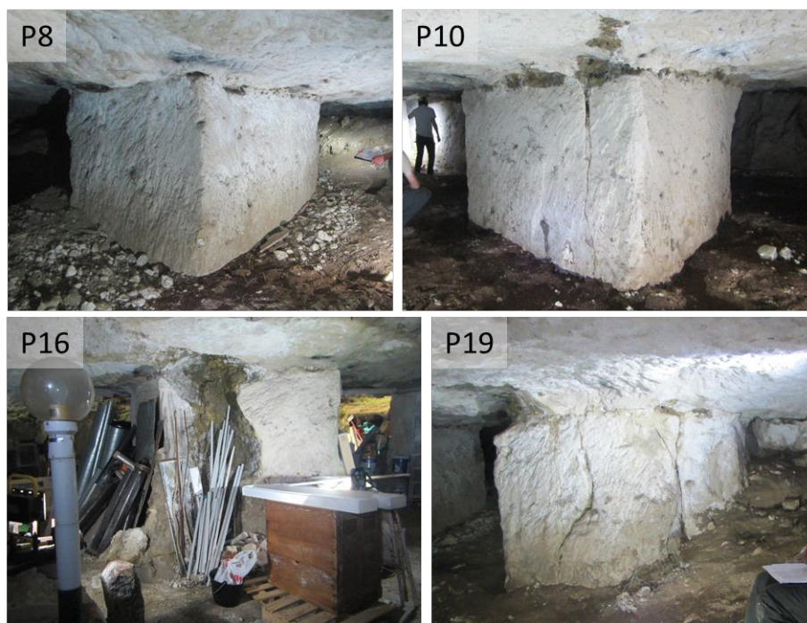
Illustration 10 : Exemples de piliers dans la carrière de Courgeon - P8 : Pilier sain ; P10 : Pilier sain, traversé par une fracture naturelle karstifiée mineure ; P16 : Pilier fracturé, traversé par une fracture naturelle karstifiée (conduit karstique) ; P19 : Pilier légèrement fracturé
