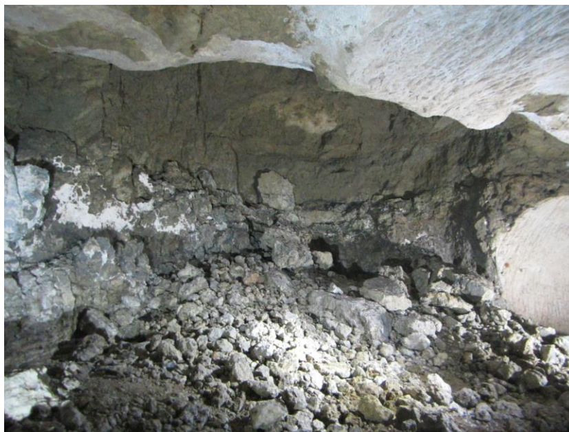
Illustration 13 : Cloche de fontis associée à un déboussage karstique (D2) dans la carrière de Courgeon
