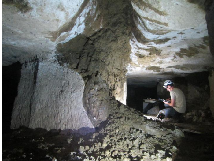
Illustration 3 : Exemple de conduit karstique visible dans la carrière de « Curiers »
