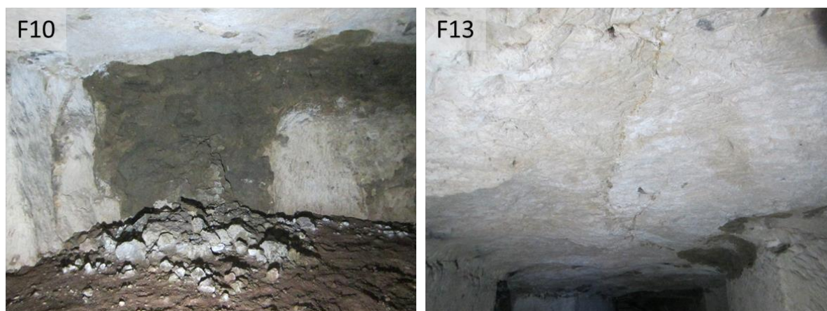
Illustration 15 : A droite : large diaclase argilisée associée à un débouurgage karstique (F10) – A gauche : ensemble de petites diaclases associées argilisées (F13)
