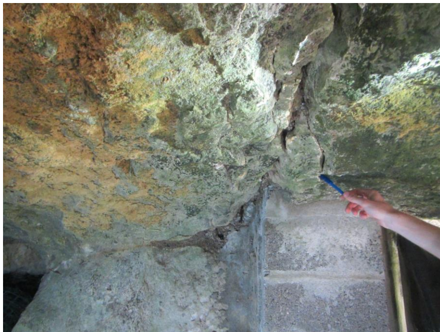
Illustration 14 : Instabilité ponctuelle dans la diaclase F6
