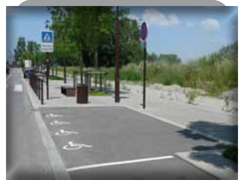
Une place de stationnement réservée disposant des signalisations verticale et horizontale en vigueur.
