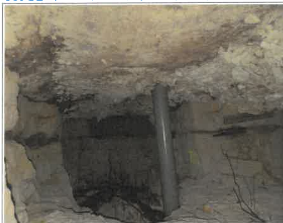
Figure III.5: pieux de confortement sous la RD628 (événement 3) et chutes de toit (événement 4).
