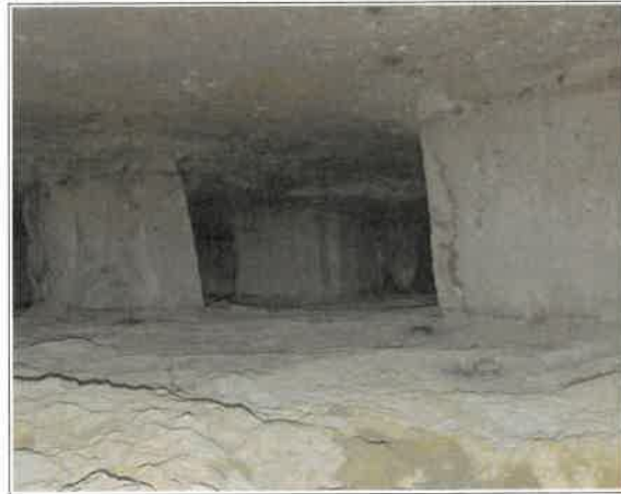
Figure III.26: vue générale de la carrière de Cuners.
