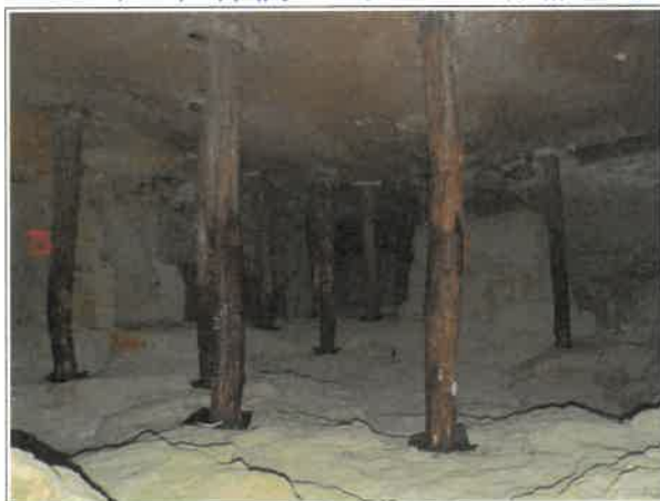
Figure III.41: zone soutenue à l'aide de poteaux en bois près de la descenterie.
