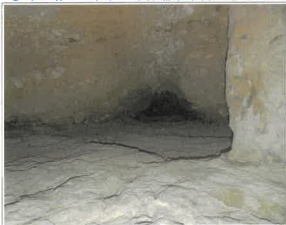
Figure III.28: Remblais à l'intérieur de la carrière de Curters.
