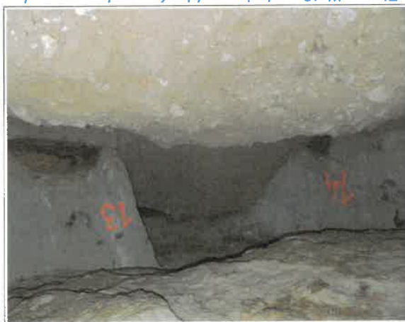
Figure III.42: galerie remblayée par bourrage de matériaux (arrière plan de la photo).
