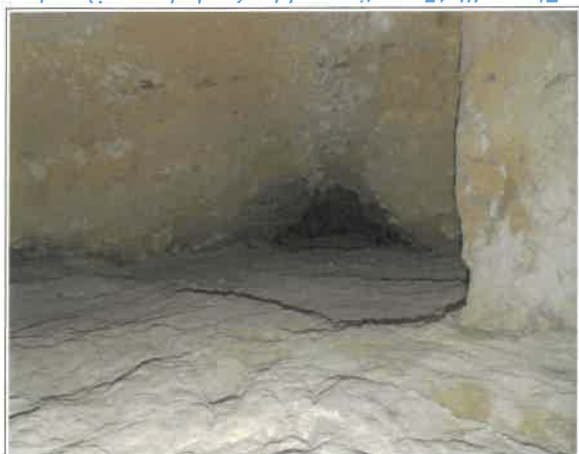
Figure III.45: partie remblayée de la carrière de Curiers.
