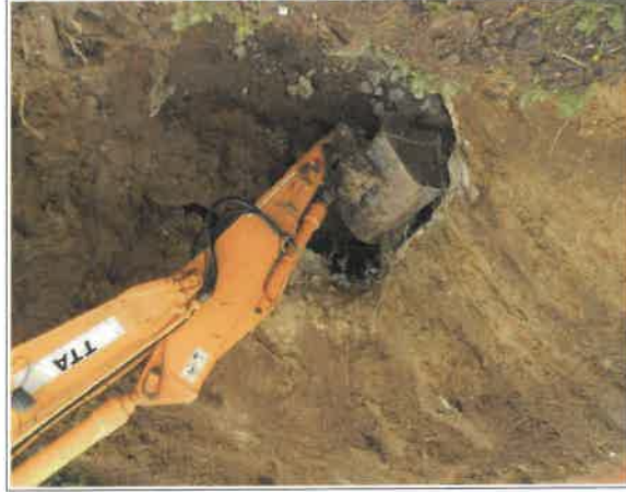
Figure III.11: ouverture de la cavité de la RD10 à la pelle mécanique.
