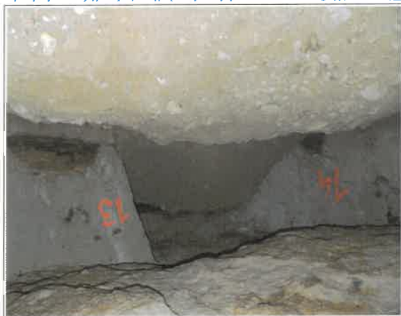
Figure III.9: zone remblayée à l'extrémité sud de la carrière du village, en direction de la RD10.
