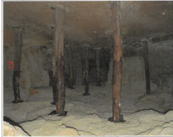
Figure III.7: zone étayée à l'aide de poteaux en bois (événement 8)
