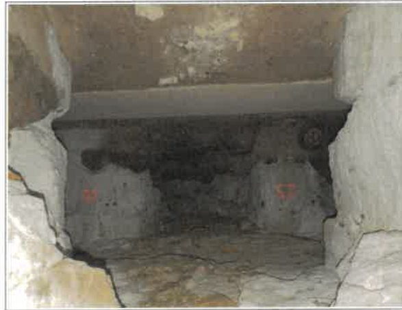
Figure III.40: vue générale de la carrière, on notera les zones de karst au niveau des piliers (taches brunes).
