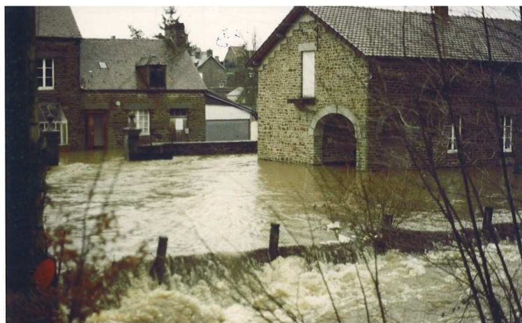
Figure n° 9 : Pont-Erambourg. Crue de la Vère en octobre 1993. Source : riverain
