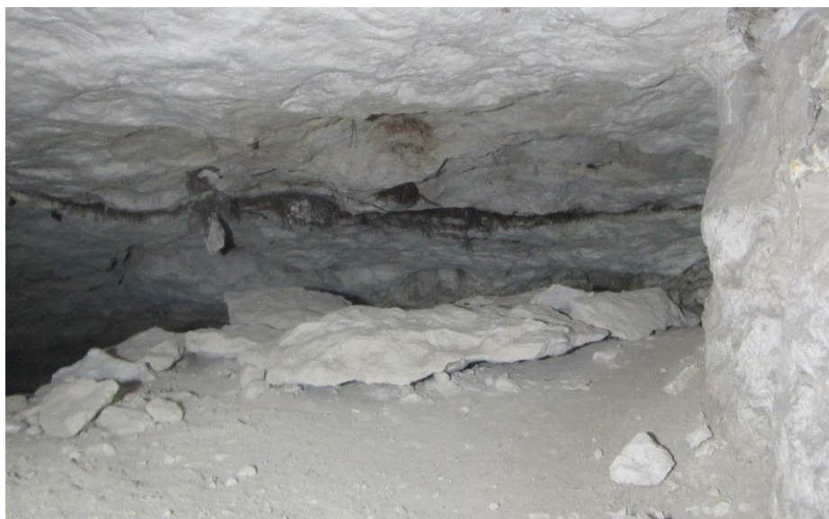
Illustration 13 : Chute de toit (D10) délimitée par une diaclase argilée dans le secteur sud de la carrière de Condeau
