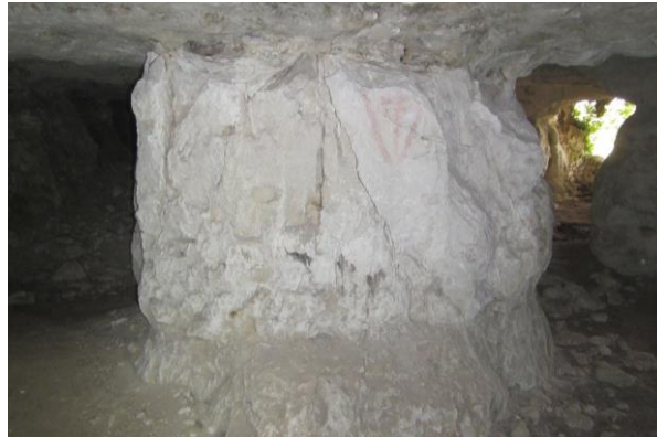
Illustration 7 : Exemple de pilier fracturé mécaniquement (P12) dans la carrière de Condeau
