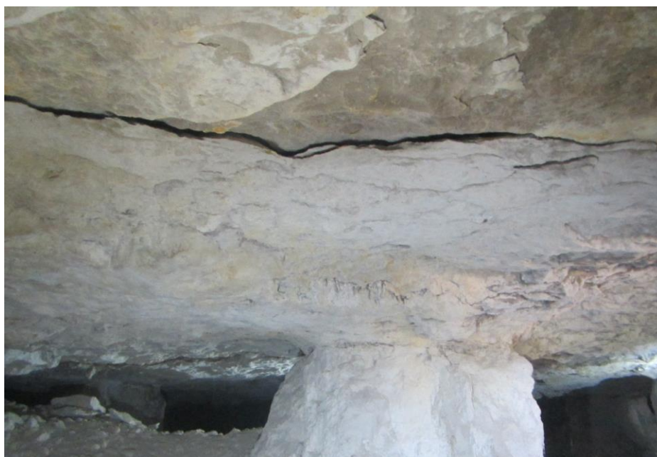
Illustration 10 : Décollement de premier banc (D9) dans la carrière de Condeau
