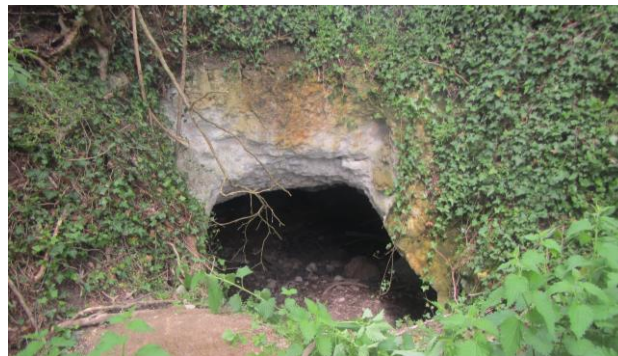
Illustration 4 : Vue sur le cavage qui permet d'accéder à la carrière souterraine de Maisoncelle
